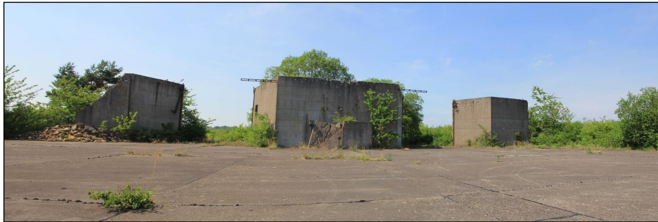
Photo 76 : 3 bâtis en ruine au nord du point de vue n°51
