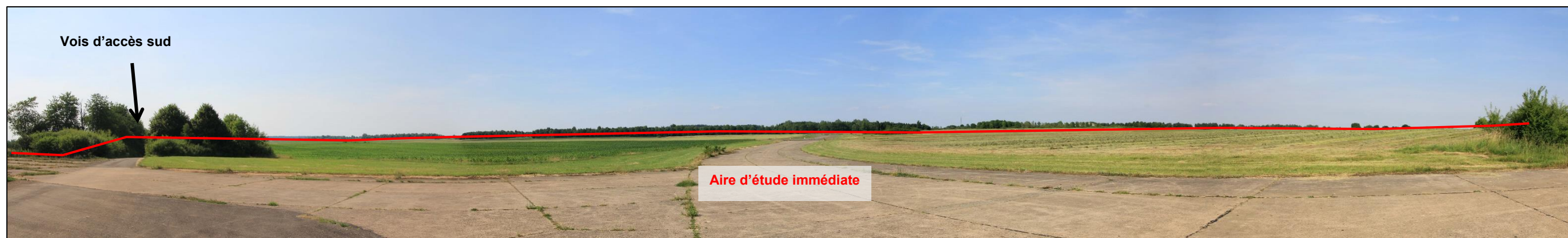
Photo 86 : Prise de vue n°61 (ATDx, juin 2017) vers le nord
