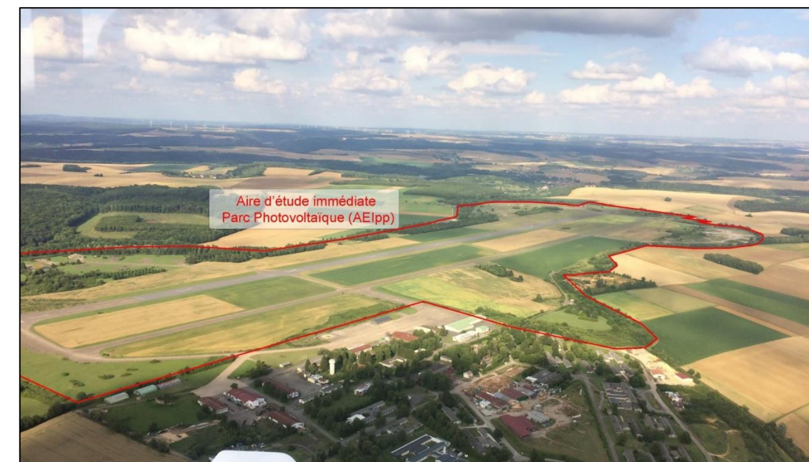
Photo 13 : Vue aérienne de l'aire d'étude immédiate du parc Photovoltaïque
