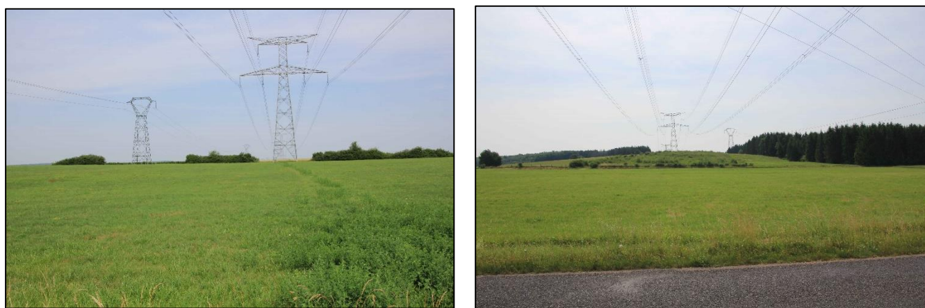
Photo 97 : Lignes électriques THT RTE en bordure des AEIps1 et AEIps2 vers l'Ouest (à gauche) et vers l'Est (à droite) (Source : ATDX juin 2017)
