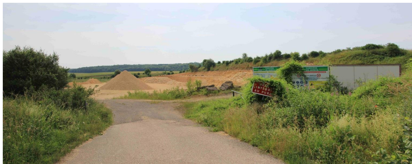
Photo 10 : Extraction de matériaux au sein de la carrière de Jametz
