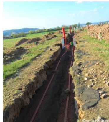
Photo 8 : Tranchée pour câblage
